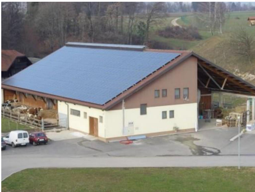
Slika 11-11: Sončna elektrarna na strehi objekta
