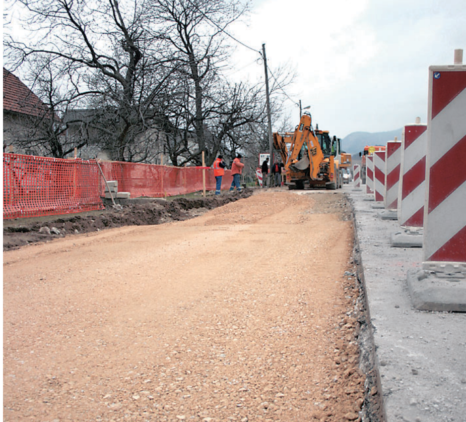
Gradnja pločnika ob glavni cesti skozi Žirovnico
