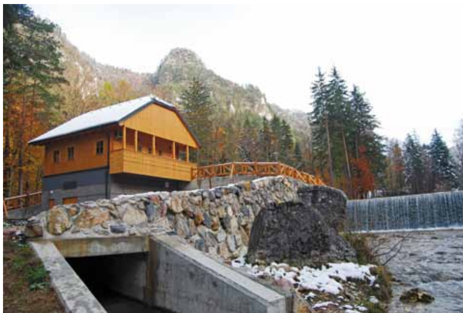
Mala hidroelektrarna Bukovlje z gostinskim lokalom
