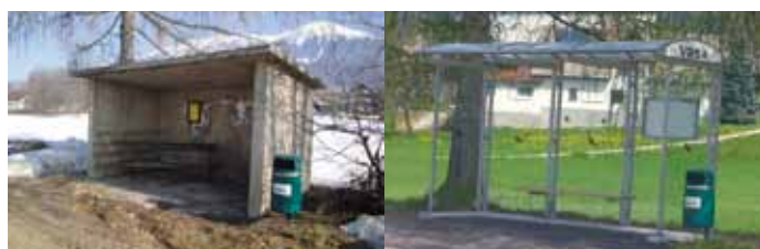
V Vrbi, ob regionalni cesti Žirovnica–Lesce, sta bili odstranjeni stari in nameščeni novi nadstrešniki na avtobusnih postajališčih.
