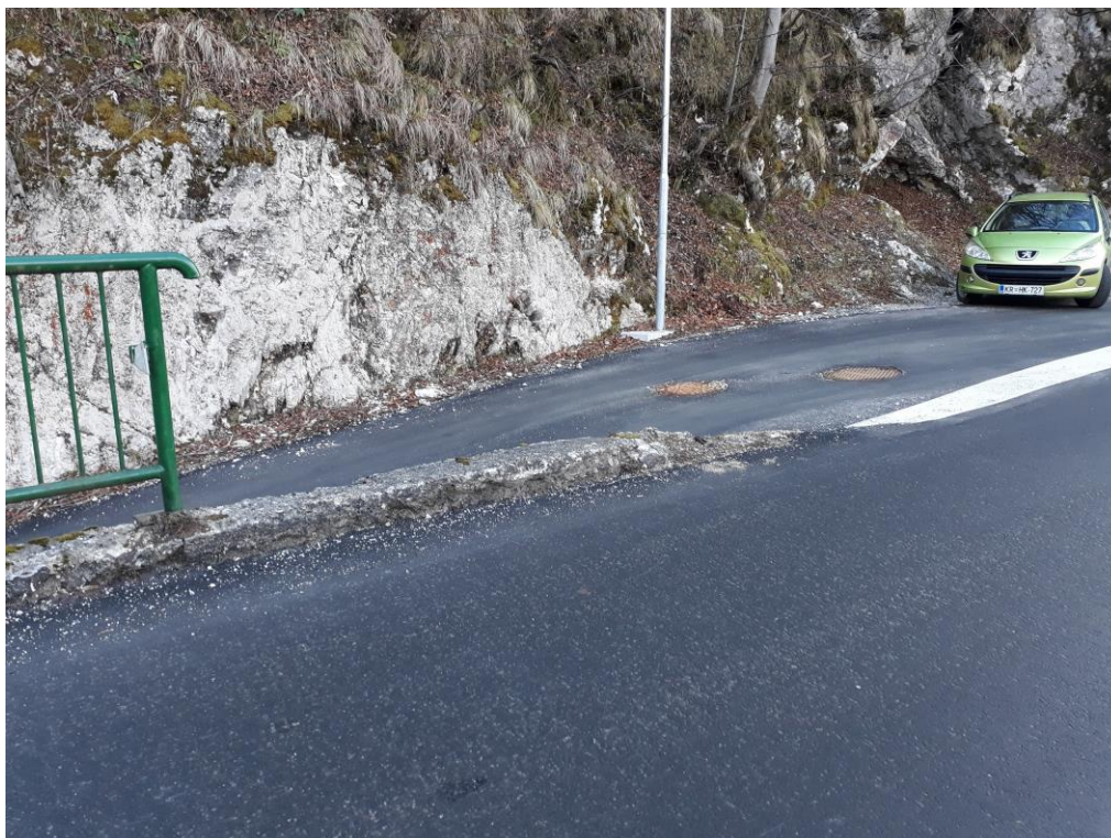
Vrhnji del na začetku opornega zidu
