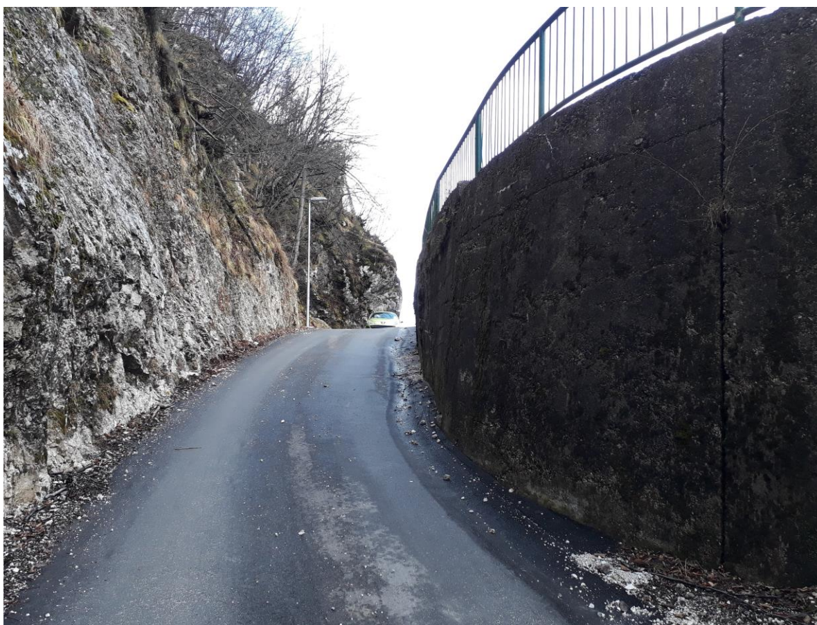
Spodnji del opornega zidu
