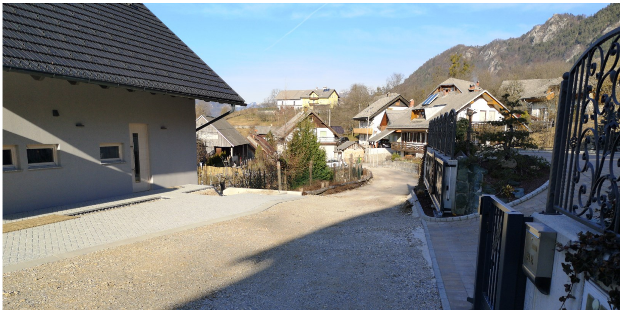
Slika 1: Pogled na obstoječe makadamsko vozišče v smeri proti priključku.
