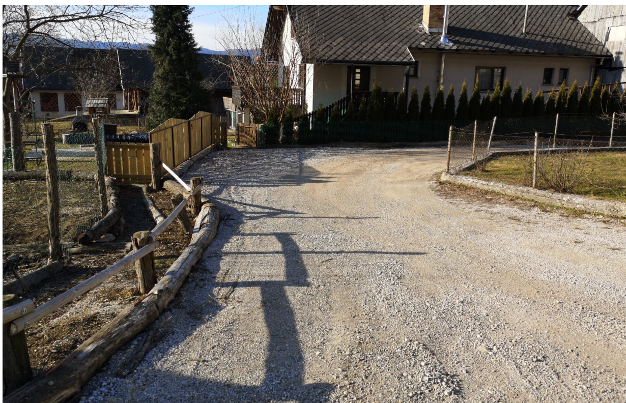
Slika 3: Pogled na obstoječe makadamsko vozišče v smeri proti priključku.
