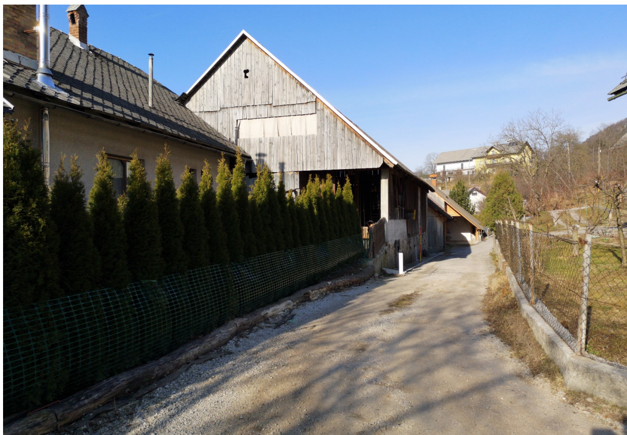
Slika 4: Pogled na obstoječe makadamsko vozišče v smeri proti priključku.
