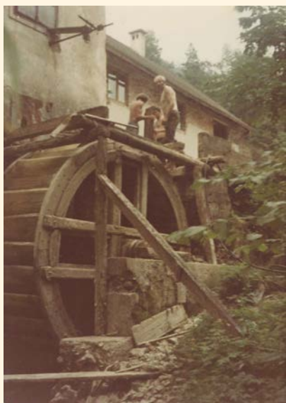
Originalno pogonsko vodno kolo se je vrtelo do leta 1978, ko ga je zamenjala turbina.
