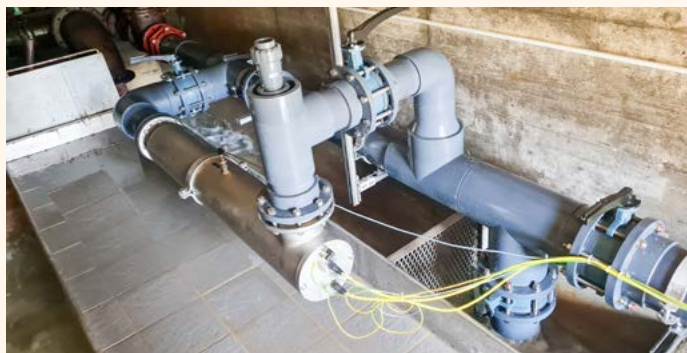
UV dezinfektor na vodnem viru Završnica
