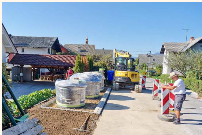
Gradnja podzemnega eko otoka na Bregu
