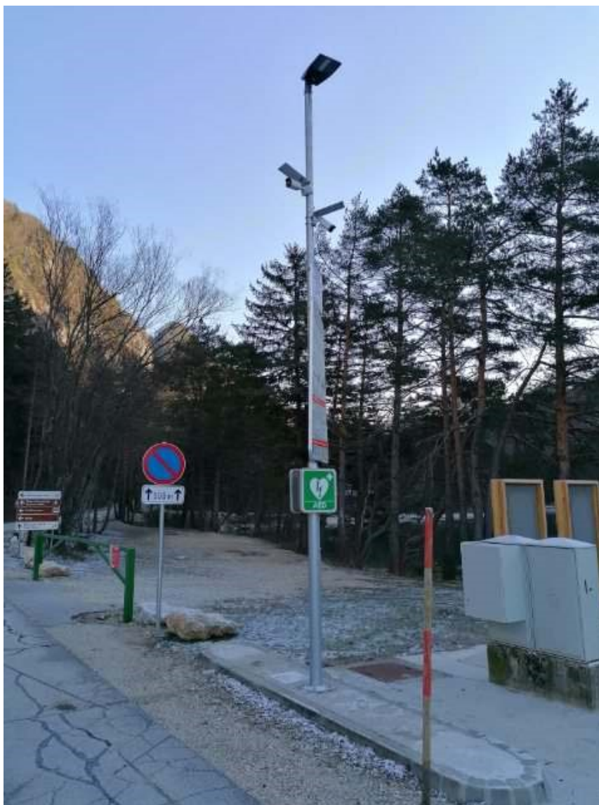
Fotografija lokacije obeh kamer
