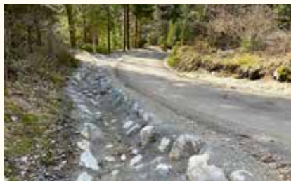
Na cestah je izvedenih več kilometrov koritnic za odvajanje meteornih voda.
