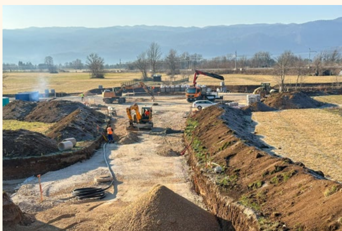
Gradnja priključka obvoznice na državno cesto Radovljica–Jesenice
