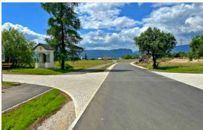
Obnovljena cesta Breznica–Vrba s pasom za kolesarje
