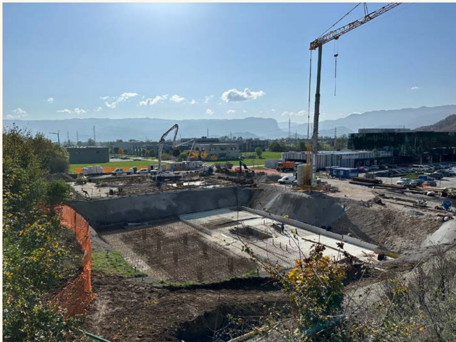
Gradbišče v Poslovni coni Žirovnica
