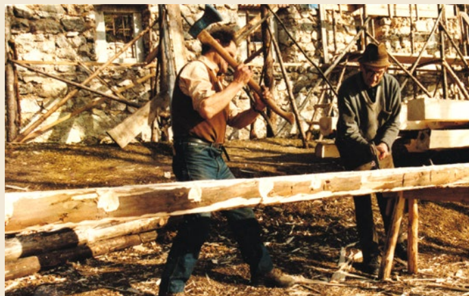
29. novembra 1991 se je pričelo tesianje lesa. Prva sta se tega opravila lotila Ivan Zupan – Mrtnač (avtor načrtov nove cerkve) in Janez Sodja – Fržinc.
