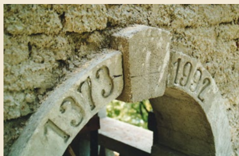
Line zvonika iz betonskih elementov so izdelali pozimi leta 1992 v garaži pri družini Jelič – Pintar.
