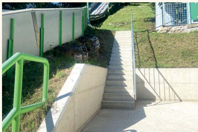
Obnovljeni oporni zidovi in stopnišča
